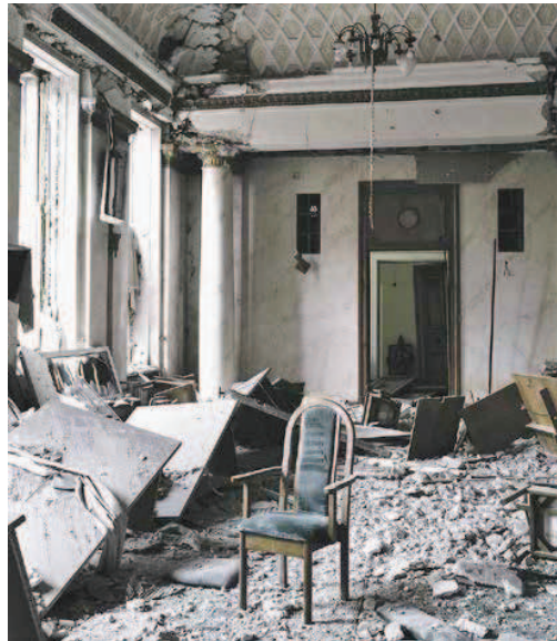
Charkiw, im April 2022: Ein von russischem Militär zerstörtes Verwaltungsgebäude. Foto: Shin Yahiro/Redux/laif
